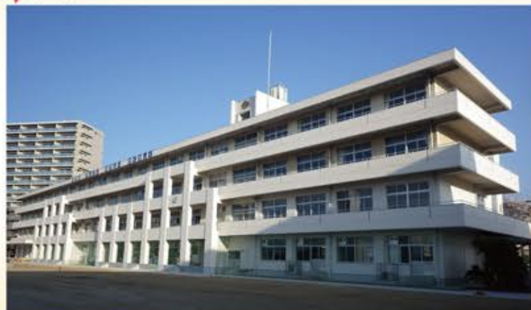
【工事名】今市小学校南校舎耐震補強及び改修建築工事
