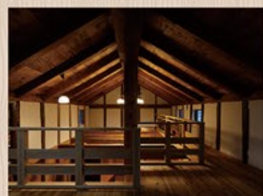
2階のスペースも広々と落ち着いた空間が出来ています。
